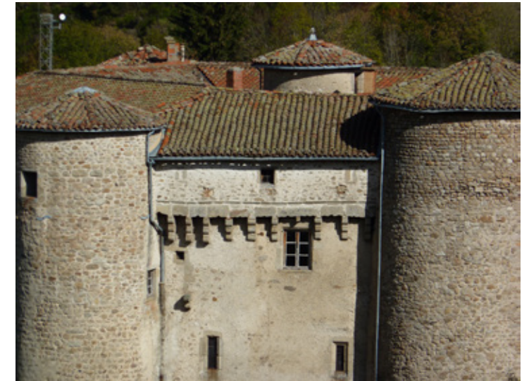
Château de Chalmazel. Détail de courtine crénelée avec chemin de ronde entre deux tours d'angle.
