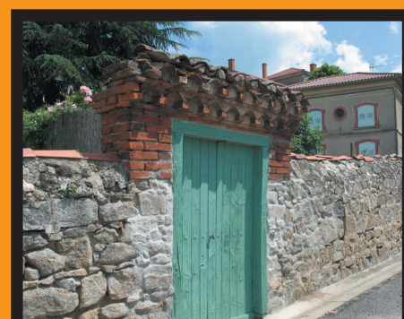
Muret en pierre
