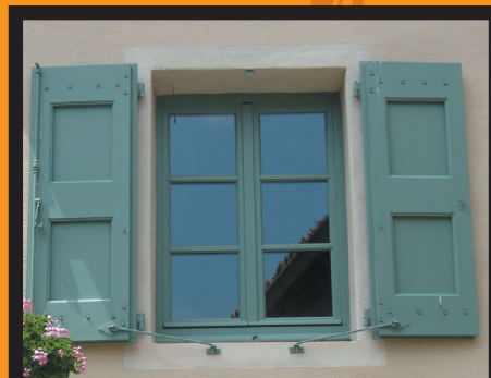
Fenêtre à six carreaux et volets pleins
