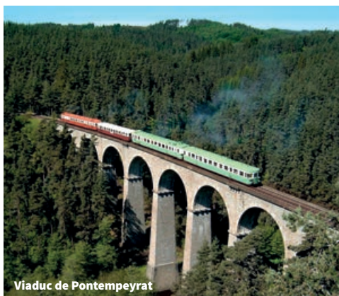
Viaduc de Pontempeyrat
