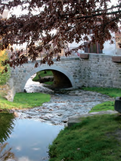
Le pont de Ruillat
