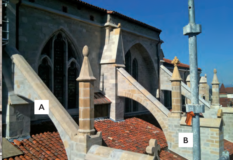
Collégiale Notre-Dame-d'Espérance - détail A/arc-boutant - B/culée
