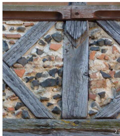
2. Détail du garde-corps de la galerie en bois avec un remplissage de moellons de basalte, tuileaux et liant à la chaux
