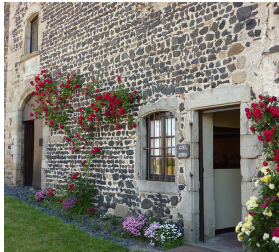
4. Accès ouest aux bâtiments conventuels
